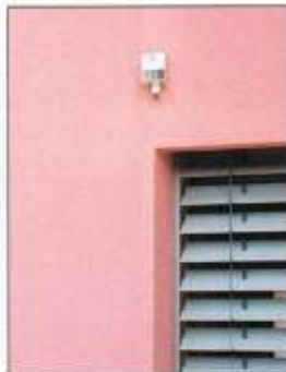
Capteur de luminosité pour l'ouverture des stores.
