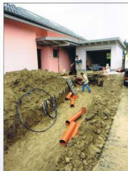
Mise en place du puits canadien (nov. 2006).
