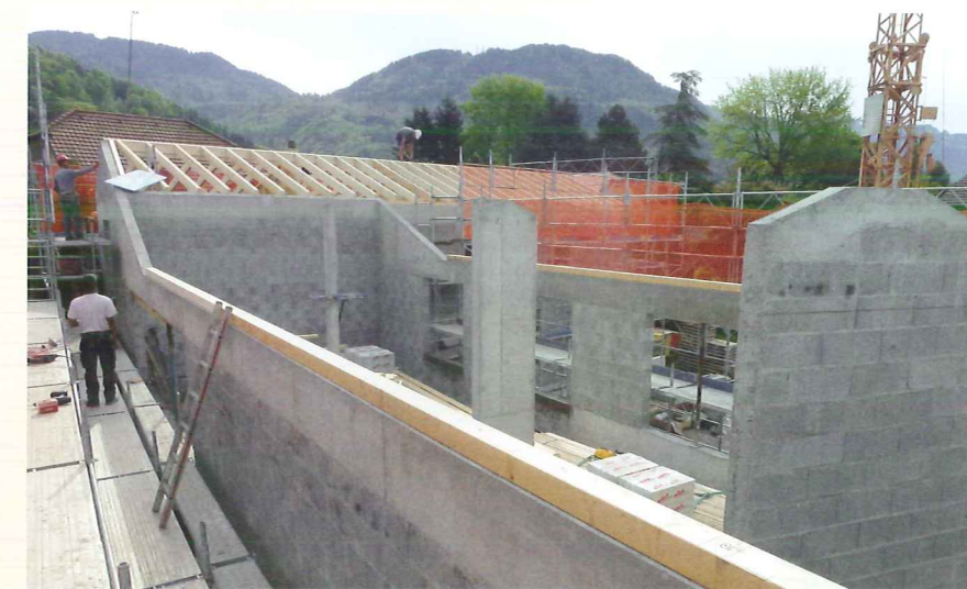
Les chevrons sont posés un à un.
