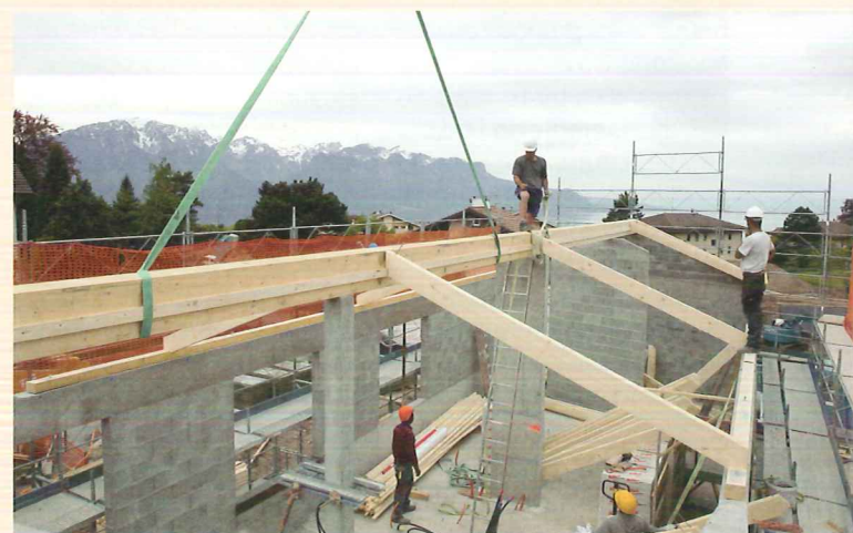
Le faite et les sablières sont posés en premier.
