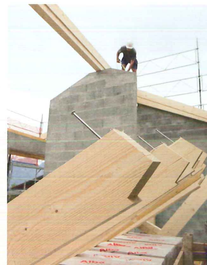
Les chevrons sont dimensionnés en atelier avant d'être posés sur place.
