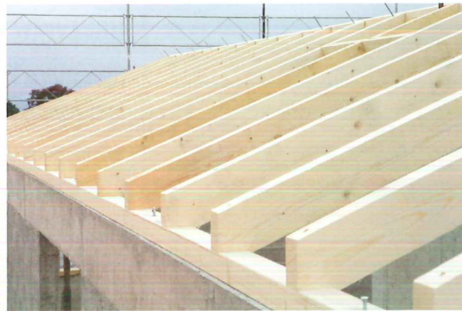
Les chevrons sont fixés aux sablières.
