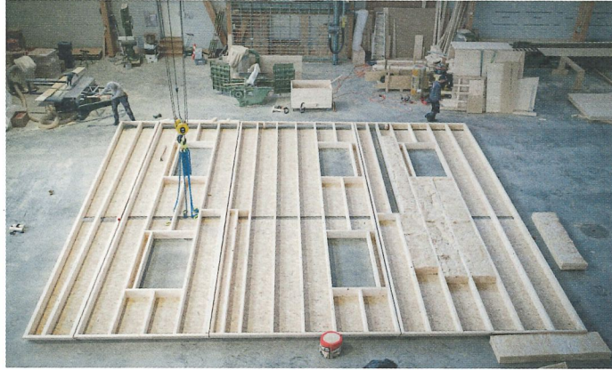
/ Les ouvriers sont en train de monter des façades entières.
