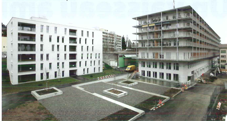
Les étages supplémentaires ont été posés sur des consoles métalliques.
